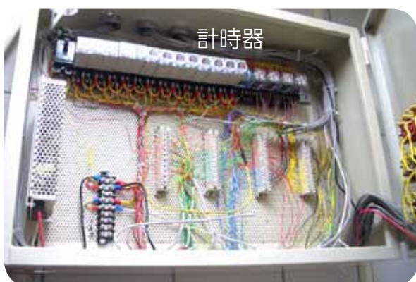
▲ 圖 3 控制盤內之計時器
